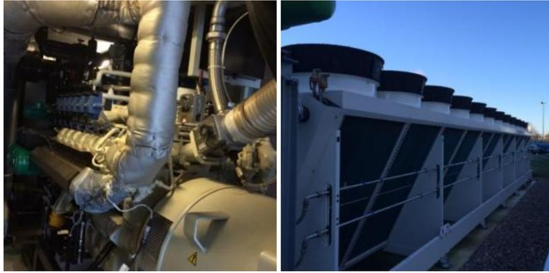
Abb. 51: BHKW in Containerbauweise im Außenbereich (li.); Tischkühler für das BHKW (re.)
