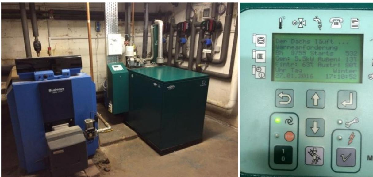
Abb. 63: Buderus Heizkessel (li.) und Dachs Mini-BHKW (re.)
