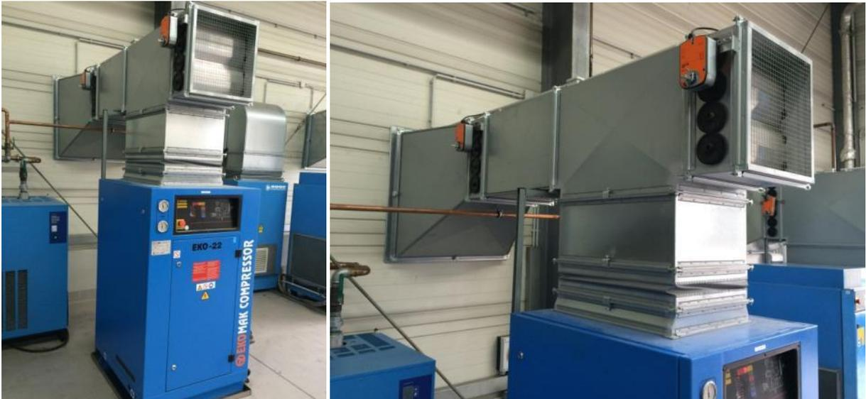
Abb. 49: Vorrichtung zur gesteuerten Abwärmenutzung der Druckluftkompressoren
