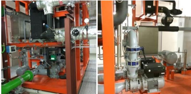
Abb. 52: Ammoniak-Absorptionswärmepumpe
