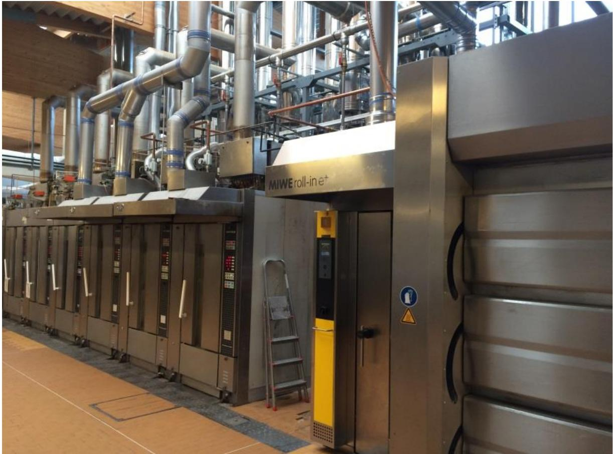
Abb. 60: Backöfen der Bäckerei Günther GmbH. Diese wurden zeitnah durch neue Öfen ersetzt
